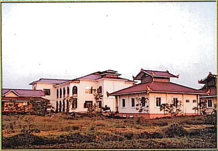
ရန်ကုန်မြို့၊ ပုလဲမြို့သစ် ဆောက်လုပ်ဆဲ သံဃာကျောင်းဆောင်သစ်များ
